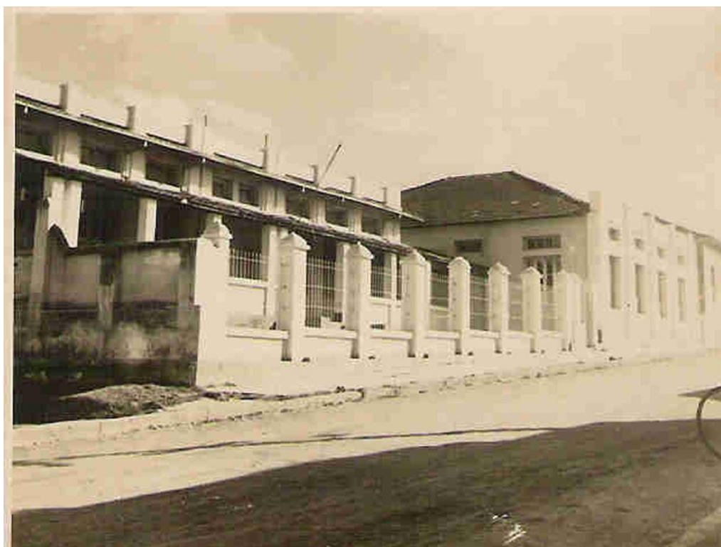
FIGURA 2 – Ginásio Padre Curvelo- Novo Prédio à Rua João Pessoa em 1931 Fonte: Jornal “Centro de Minas ”
