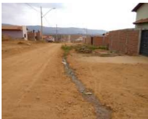
Figura 01: Esgoto a céu aberto.
