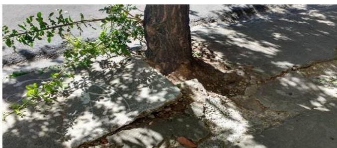
FIGURA 15 – Raízes de árvores danificando a calçada
