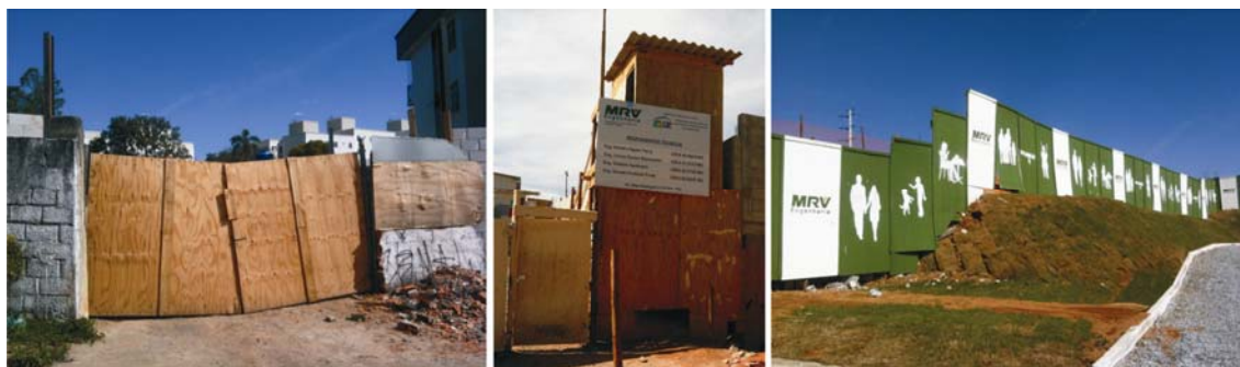
Figura 9 - Tapume de obras da Construtora MRV – Contagem/MG
