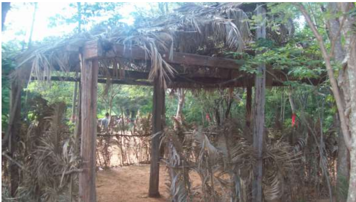
Figura 6: Esteios da casa de Rosalino Gomes de Oliveira onde aconteceu a Chacina do Sapé. Memorial na Aldeia Sapé. Foto autora, fevereiro 2018.
