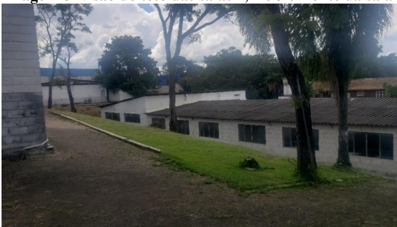
Imagem 8- visão do teto das salas 1, 2 e 3 e frente da sala 5
