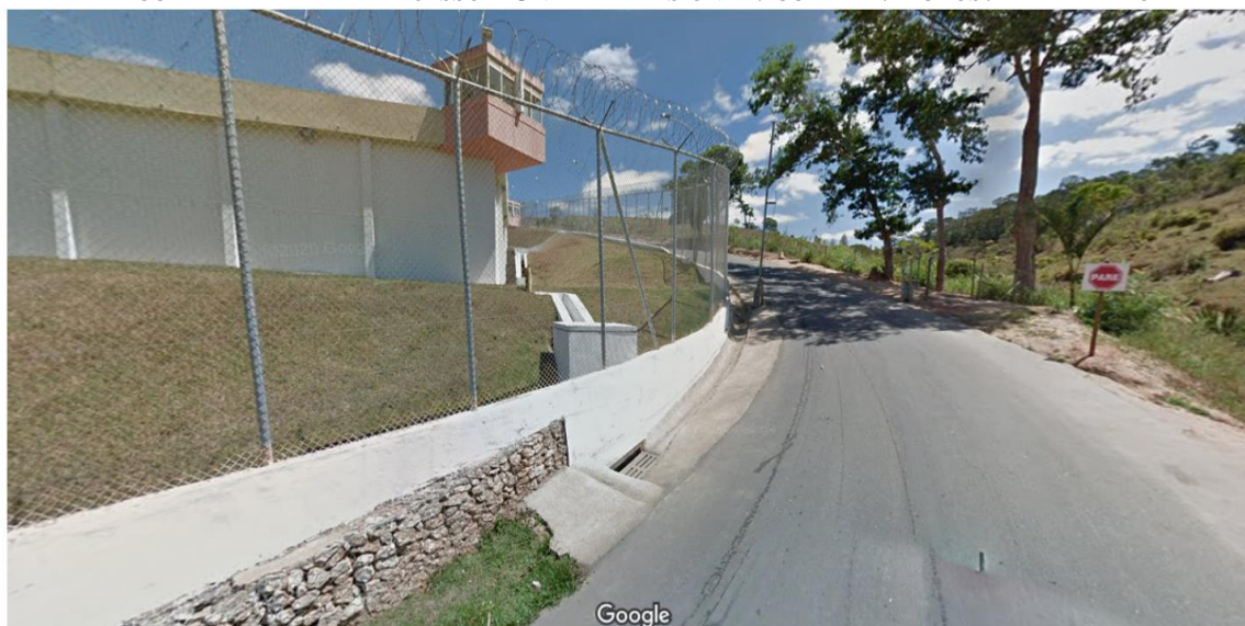
FIGURA 2 - LADEIRA DE ACESSO À UNIDADE PRISIONAL / GUARITA / MUROS / ALAMBRADO
