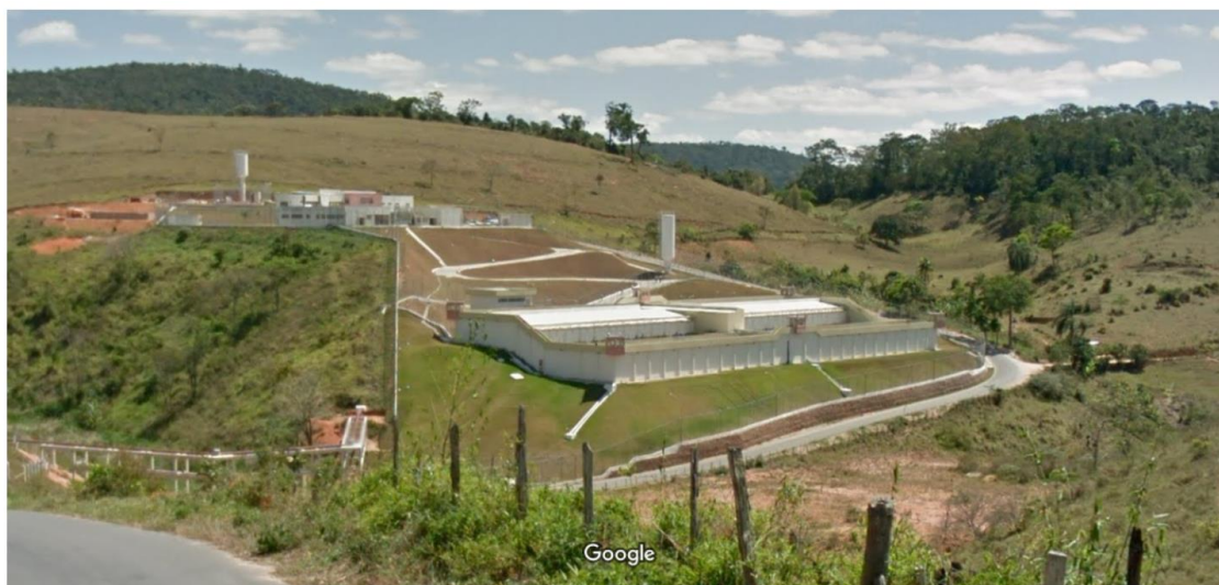
FIGURA 3 -VISÃO GERAL DO PRESÍDIO
