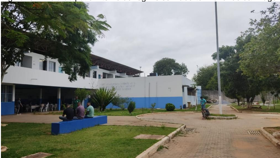
Figura 8 – Vista do pátio interno do regime semiaberto. No fundo da imagem o refeitório
