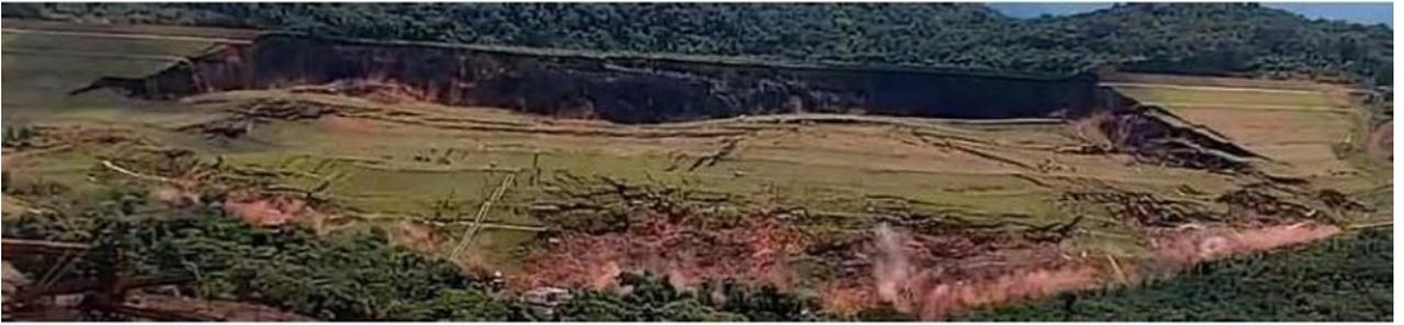
**Figura 17** - Vista Frontal do início do rompimento da Barragem 1 - Mina Córrego do Feijão, Complexo Paraopeba - VALE S. A., Brumadinho/MG
