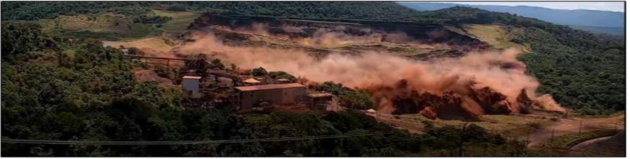
**Figura 20** - Vista Frontal do início do rompimento da Barragem 1 - Mina Córrego do Feijão, Complexo Paraopeba - VALE S. A., Brumadinho/MG
