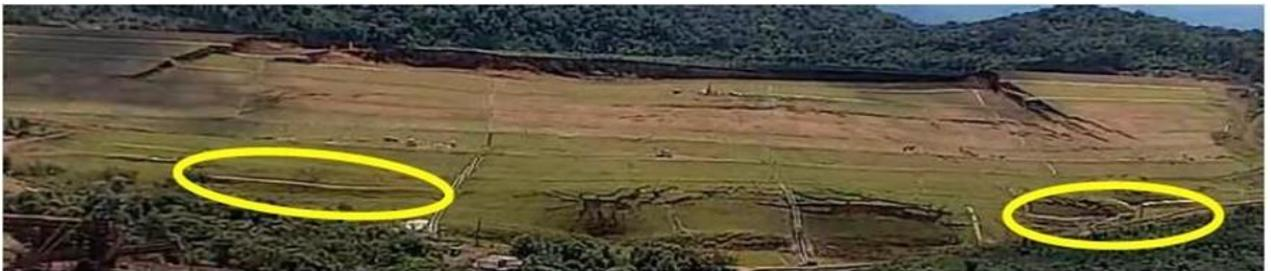
**Figura 13** - Vista Frontal do rompimento da Barragem 1 – Mina Córrego do Feijão, Complexo Paraopeba VALE S. A., Brumadinho/MG
