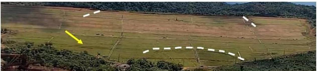
**Figura 11** - Vista Frontal do início do rompimento da Barragem 1 – Mina Córrego do Feijão, Complexo Paraopeba – VALE S. A., Brumadinho/MG
