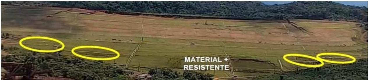
**Figura 12** - Vista Frontal do início do rompimento da Barragem 1 – Mina Córrego do Feijão, Complexo Paraopeba – VALE S. A., Brumadinho/MG
