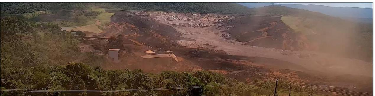
**Figura 22** - Vista Frontal do início do rompimento da Barragem 1 - Mina Córrego do Feijão, Complexo Paraopeba - VALE S. A., Brumadinho/MG
