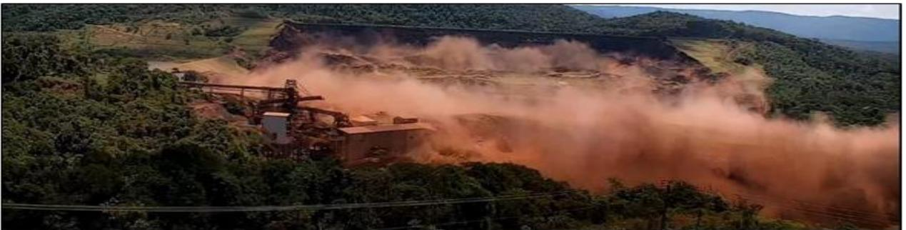
**Figura 21** - Vista Frontal do início do rompimento da Barragem 1 - Mina Córrego do Feijão, Complexo Paraopeba - VALE S. A., Brumadinho/MG
