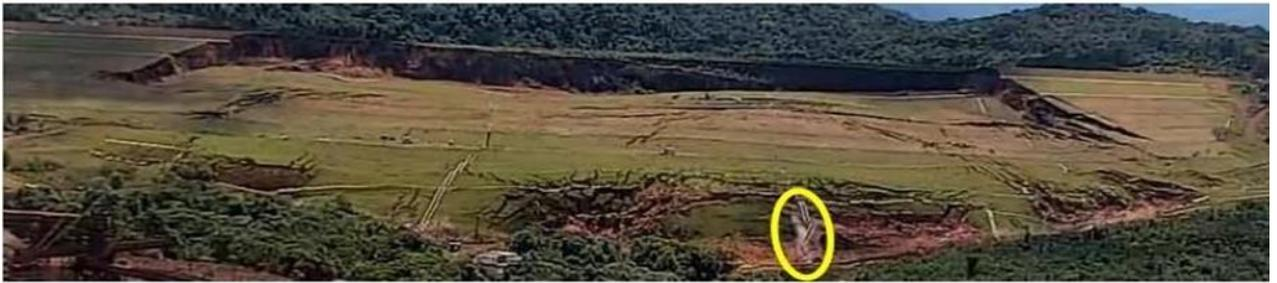
**Figura 15** - Vista Frontal do início do rompimento da Barragem 1 – círculo amarelo realça o jorro de água saindo na parte baixa do Maciço - Mina Córrego do Feijão, Complexo Paraopeba - VALE S. A., Brumadinho/MG
