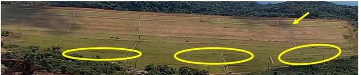
**Figura 10** - Vista Frontal do início do rompimento da Barragem 1 – Mina Córrego do Feijão, Complexo Paraopeba – VALE S. A., Brumadinho/MG
