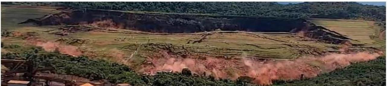
**Figura 19** - Vista Frontal do início do rompimento da Barragem 1 - Mina Córrego do Feijão, Complexo Paraopeba - VALE S. A., Brumadinho/MG
