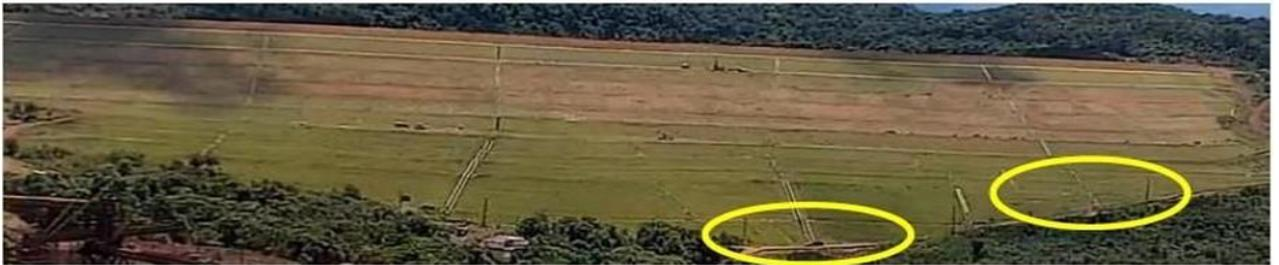
**Figura 9** - Vista Frontal do início do rompimento da Barragem 1 – Mina Córrego do Feijão, Complexo Paraopeba – VALE S. A., Brumadinho/MG
