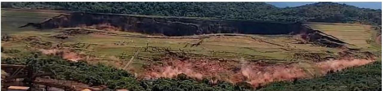
**Figura 18** - Vista Frontal do início do rompimento da Barragem 1 - Mina Córrego do Feijão, Complexo Paraopeba - VALE S. A., Brumadinho/MG
