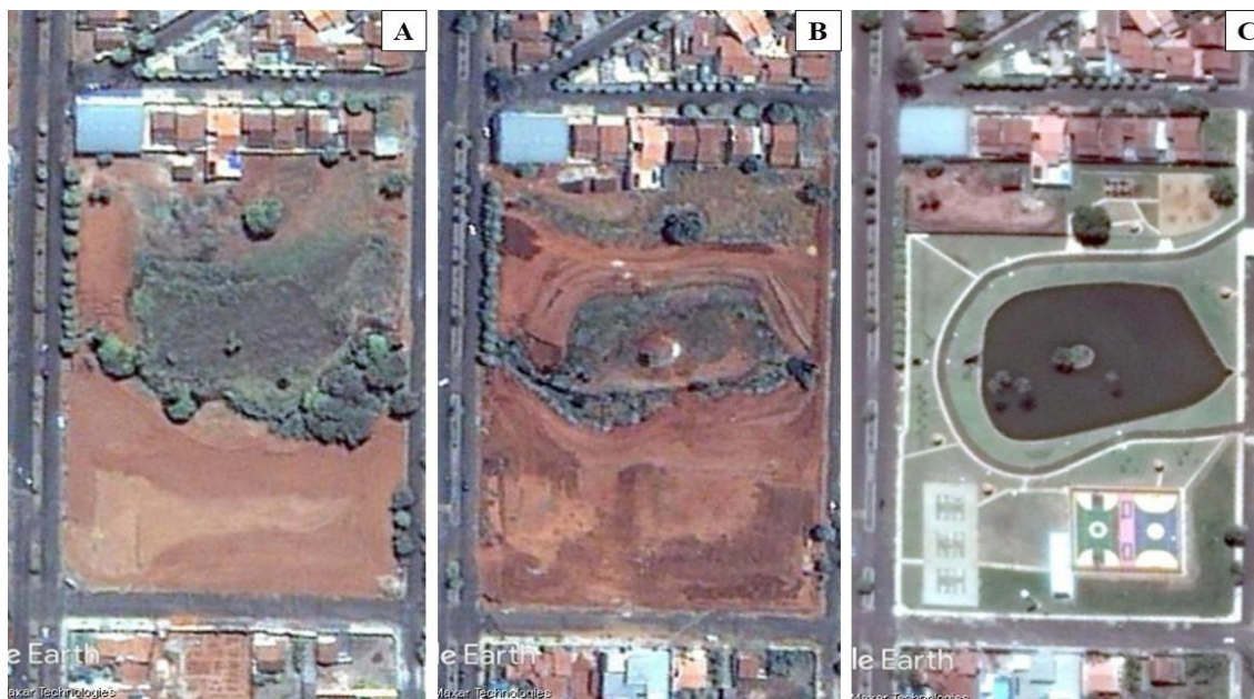
Figura 4 – (A) Local de construção de R3, como retirada da vegetação no ano de 2011; (B) processo de escavação na área de vereda para estruturação do lago no ano de 2012; (C) reservatório 3 finalizado em 2013.
