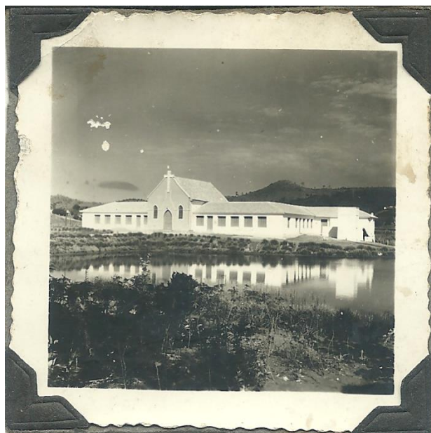
Figura 04: vista fachada do Asilo Padre José Pereira Coelho, 01/05/1951. Fonte: Arquivo da Fapam
