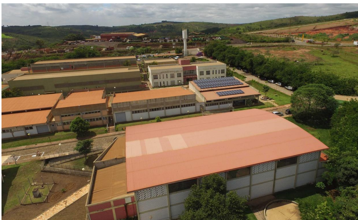
Figura 5 - Vista panorâmica do IFMG - Campus Congonhas
